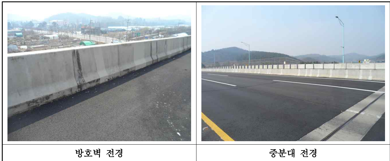
【사진 2.3.55】 방호벽 및 중분대 전경
