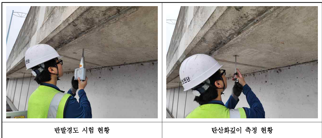
【사진 2.4.1】 콘크리트 내구성조사 현황
