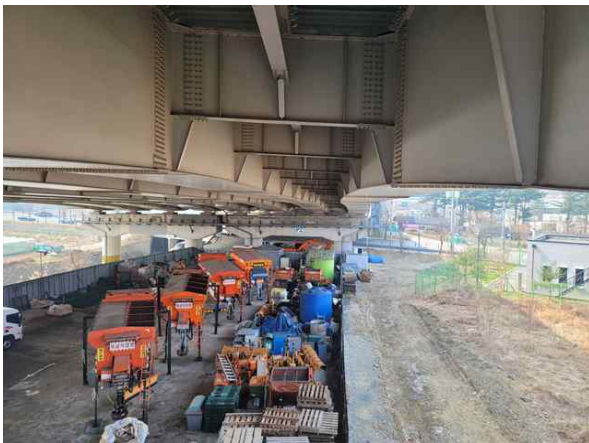
교각 P2 상태현황
