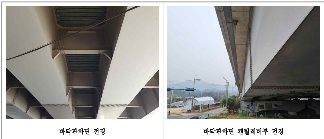
【사진 2.3.32】 바닥판하면 전경
