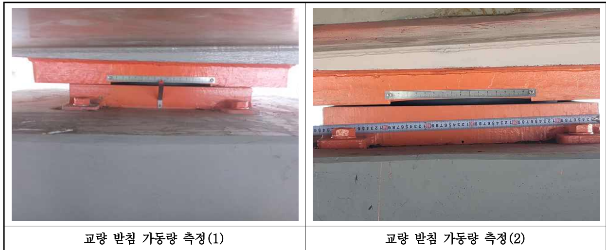
【사진 2.3.17】 교량받침 이동량 측정
