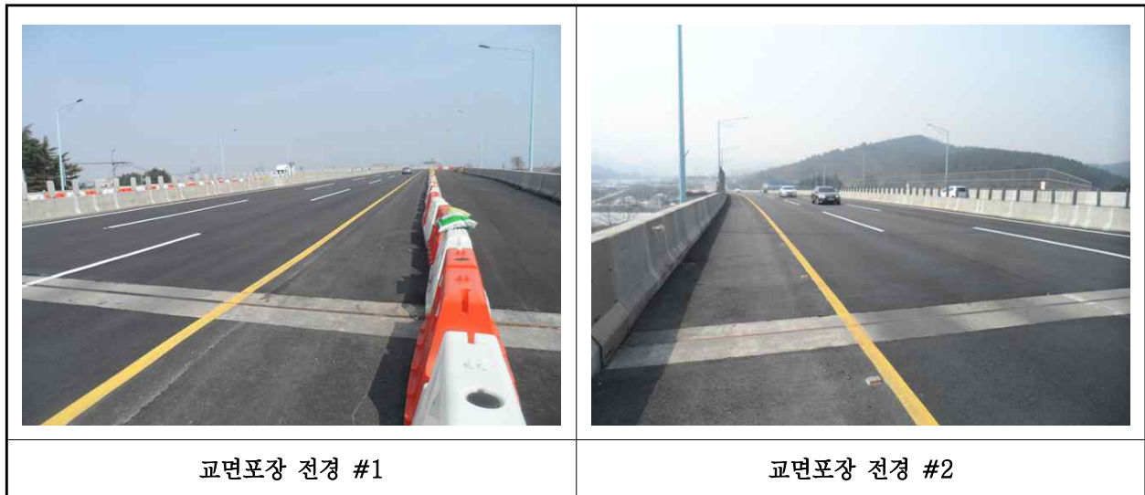
【사진 2.3.51】 교면포장 전경
