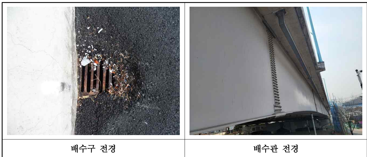
【사진 2.3.23】 배수시설 전경
