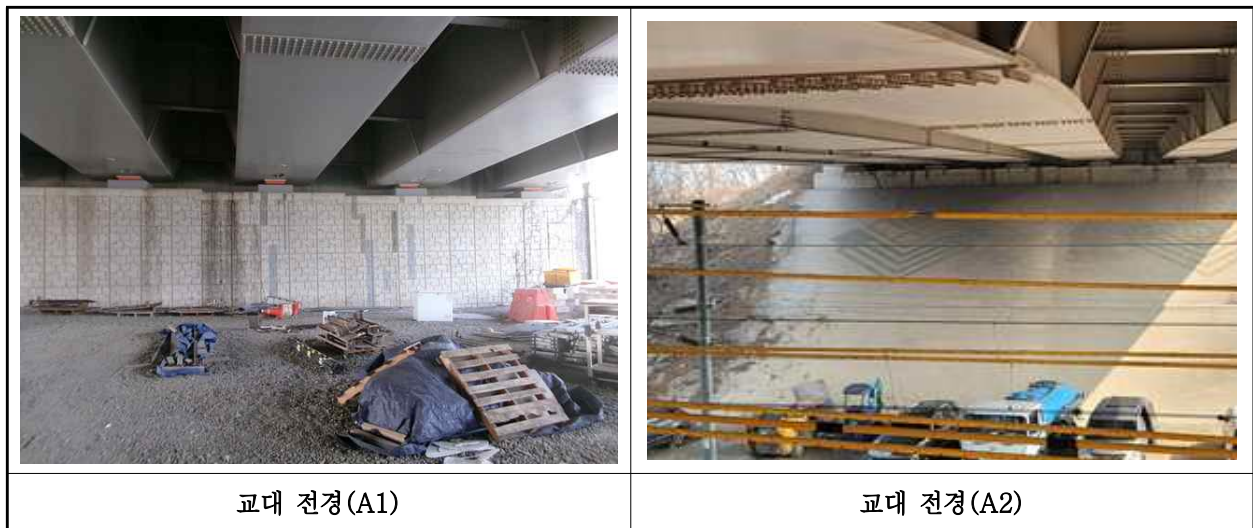
【사진 2.3.8】 교대 전경
