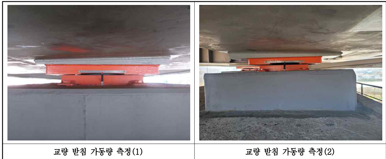
【사진 2.3.47】 교량받침 이동량 측정
