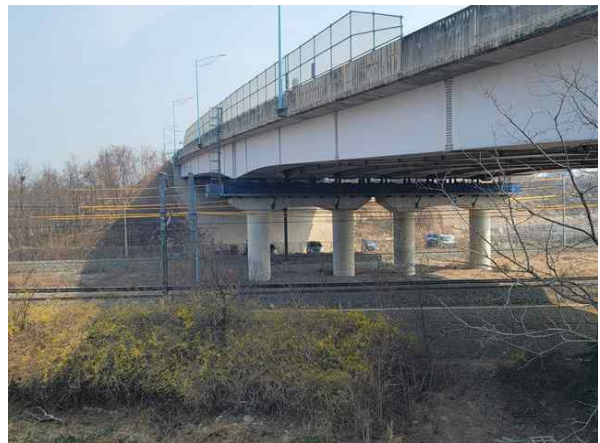
교각 P4 상태현황
