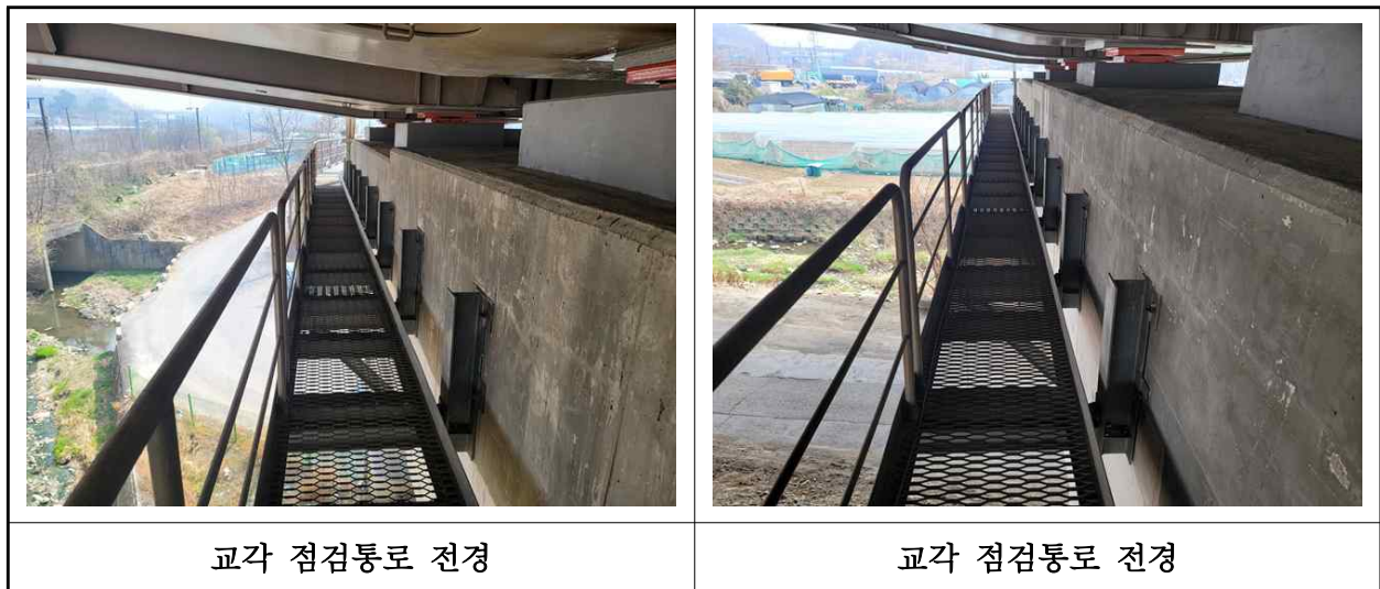
【사진 2.3.57】 교량 점검시설 전경
