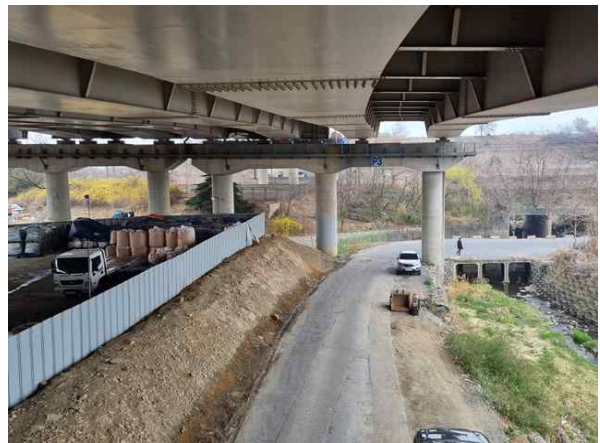
교각 P3 상태현황
