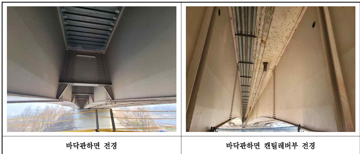
【사진 2.3.2】 바닥판하면 전경
