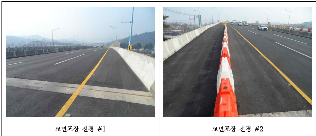
【사진 2.3.21】 교면포장 전경
