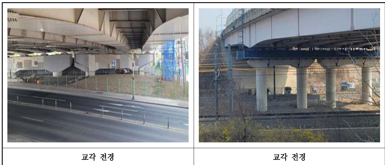
【사진 2.3.11】 교각 전경
