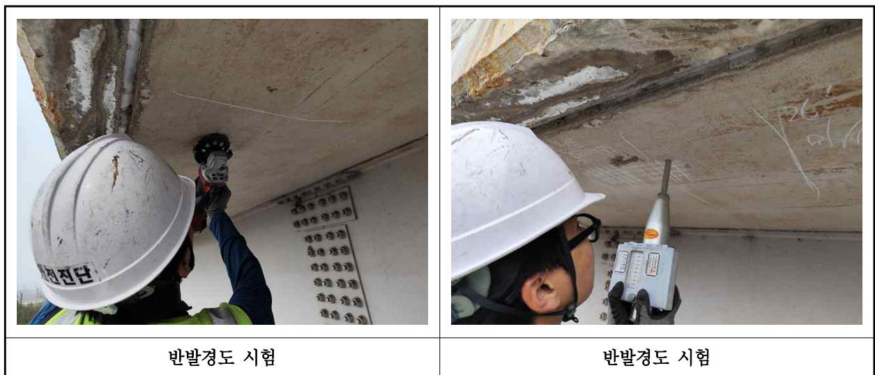
【사진 2.4.2】반발경도시험 현장사진
