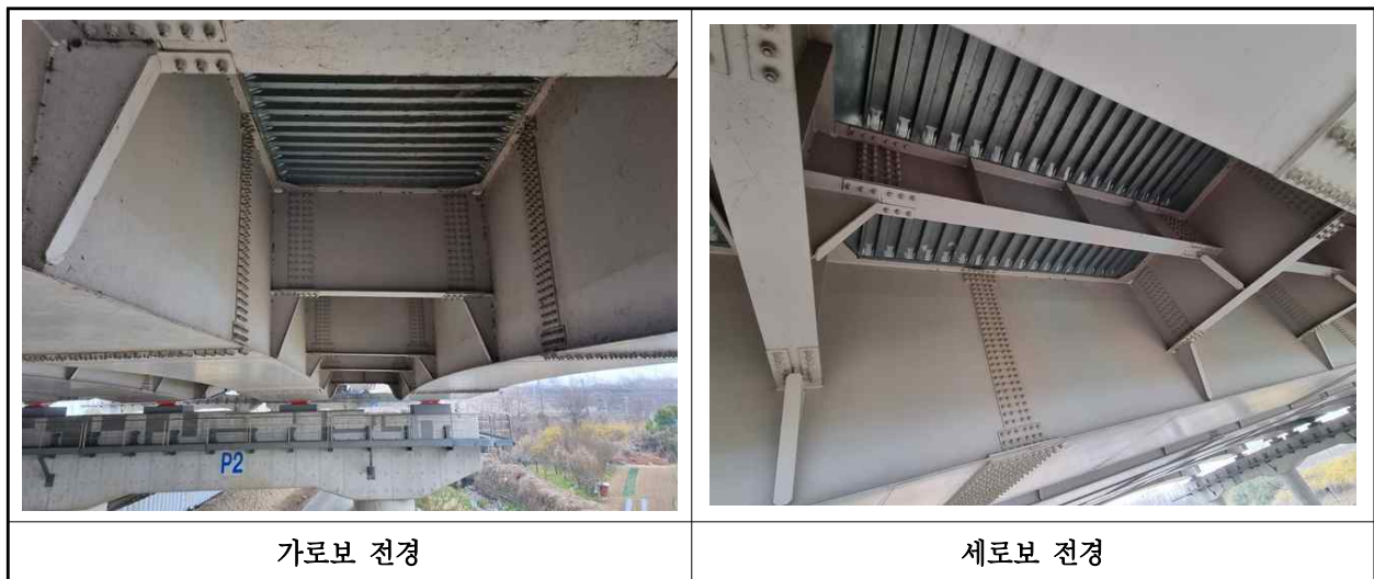
【사진 2.3.36】 가로보 및 세로보 전경
