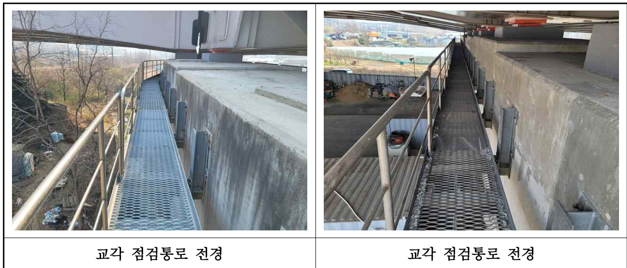
【사진 2.3.27】 교량 점검시설 전경
