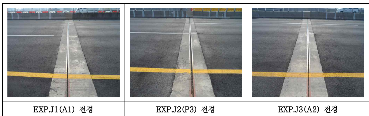
【사진 2.3.18】 신축이음장치 전경
