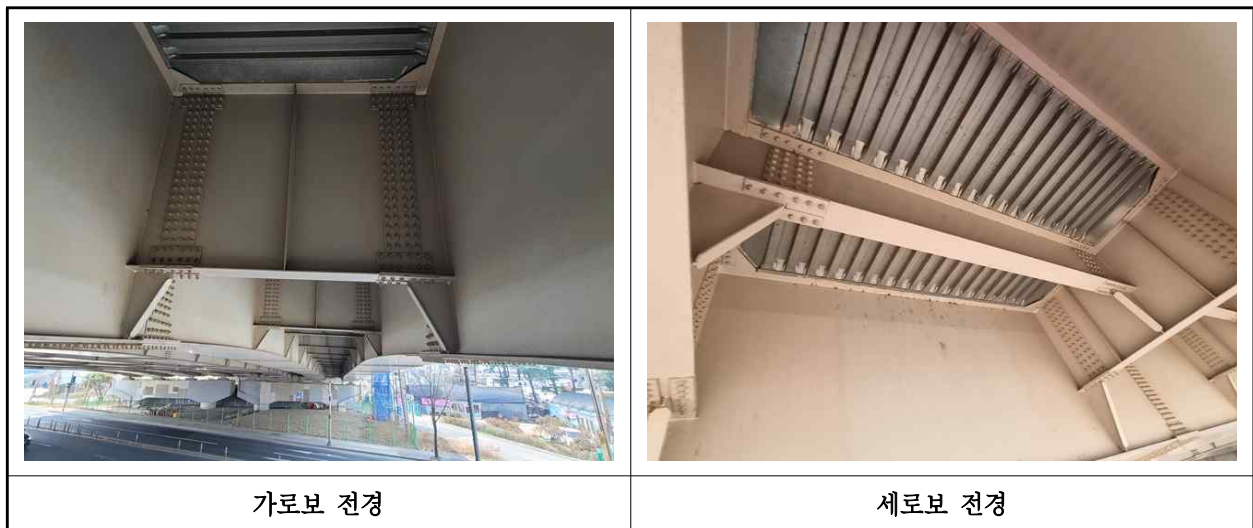
【사진 2.3.6】 가로보 및 세로보 전경
