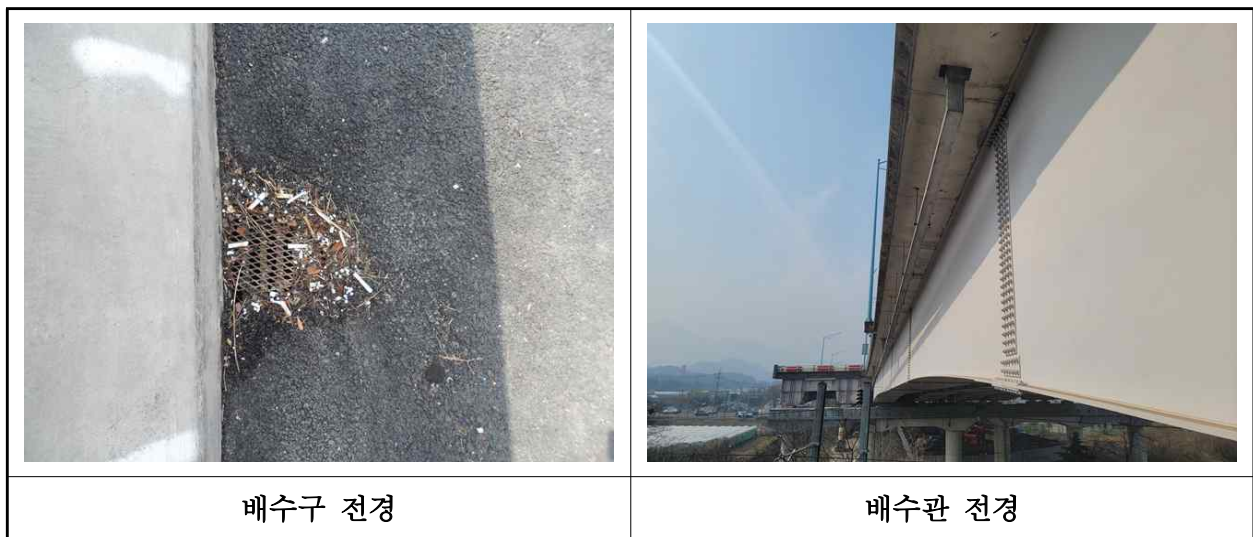
【사진 2.3.53】 배수시설 전경
