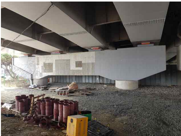
교각 P1 상태현황
