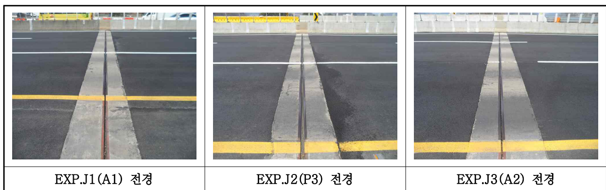
【사진 2.3.48】 신축이음장치 전경
