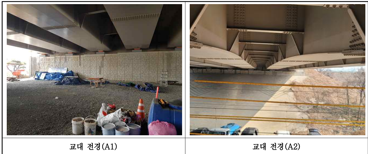
【사진 2.3.38】 교대 전경
