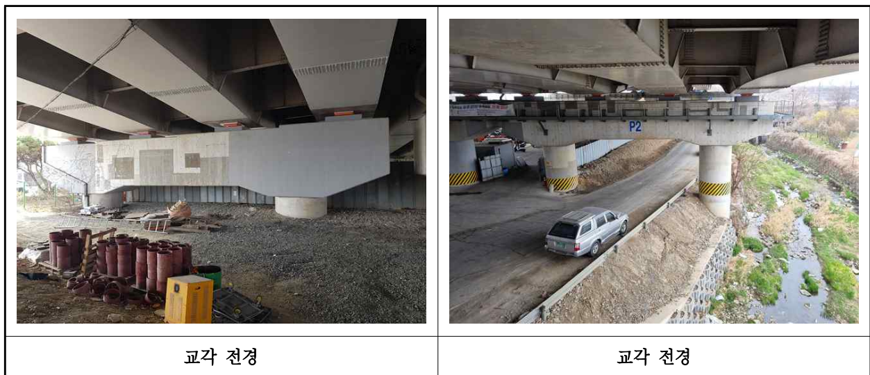
【사진 2.3.41】 교각 전경
