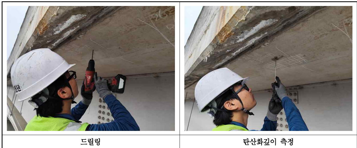
【사진 2.4.3】 탄산화 깊이 측정 현장사진
