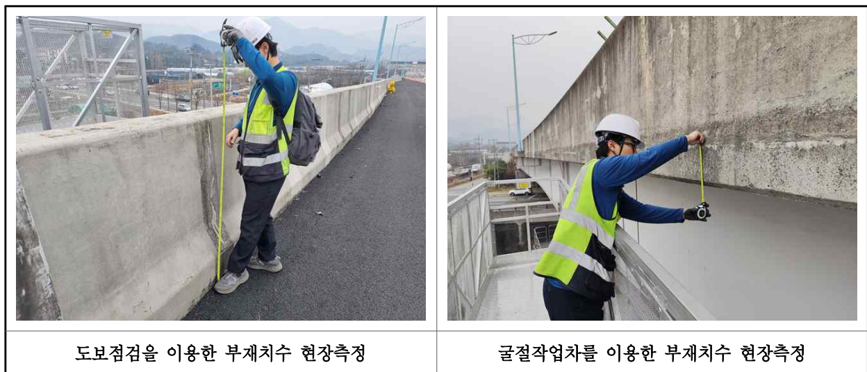
【사진 2.2.1】 부재 현장측정 전경
