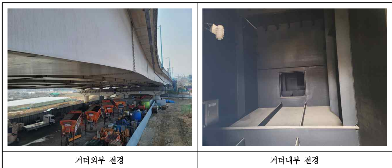
【사진 2.3.4】 거더 전경
