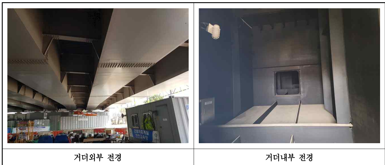
【사진 2.3.34】 거더 전경
