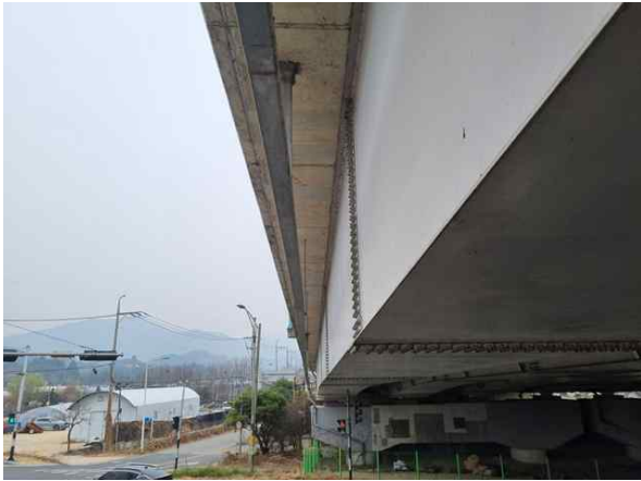
바닥판하면 S3 외측 캔틸레버 상태현황
