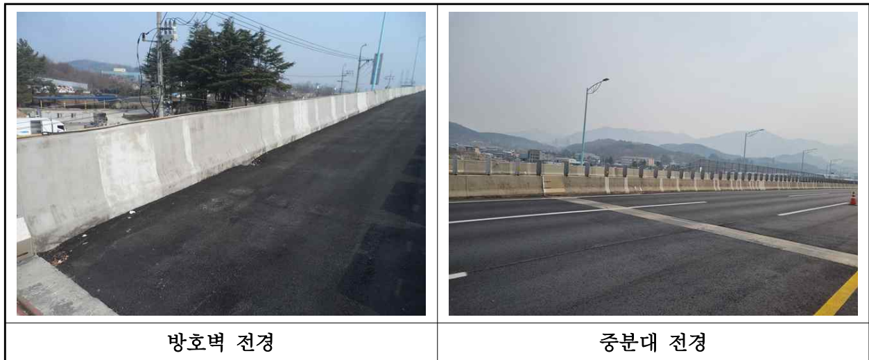
【사진 2.3.25】 방호벽 및 중분대 전경
