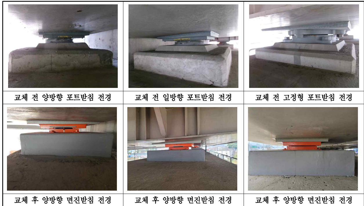
【사진 2.3.44】교량받침 전경
